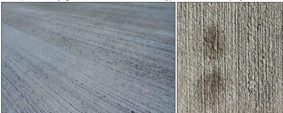
Betono paviršius brauktas šepečiu
